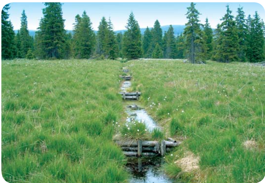
Fot. 16. Zastawki na rowie melioracyjnym w ostoi cietrzewia
